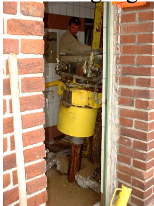
Fundament- Unterfangung
