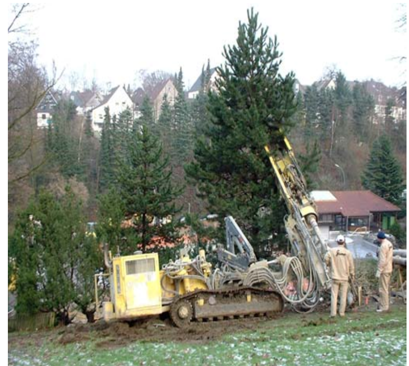
Ankerbohrgerät beim verfüllen von Hohlräumen
