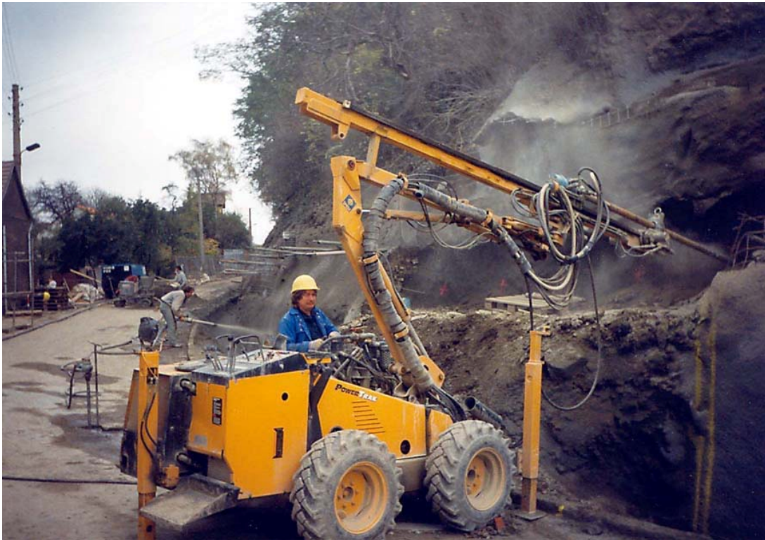
Bohrgerät zur Hangvernagelung
