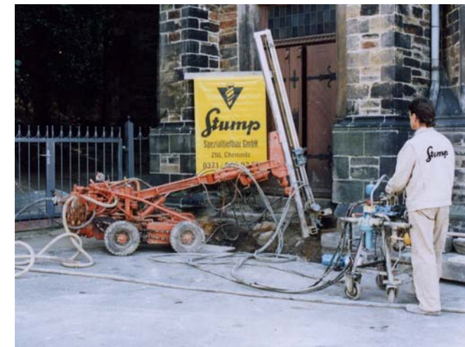
Bohrgerät beim unterfangen Eines Fundamentes
